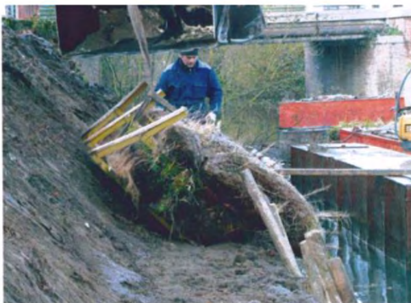
F. Mise en oeuvre des boudins d'hélophytes en pied de berge
