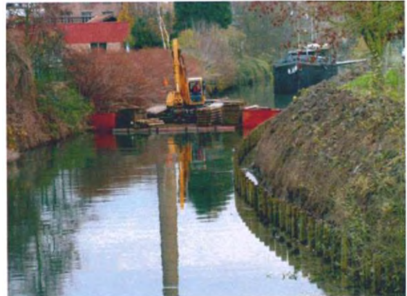
E. Mise en place des pieux de berge délimitant le parcours de pêche
